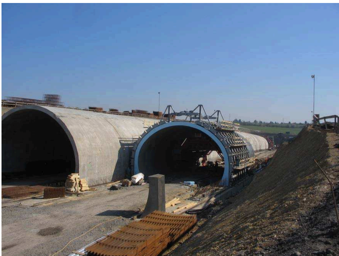
ÚSEK 514 – HLOUBENÝ TUNEL
